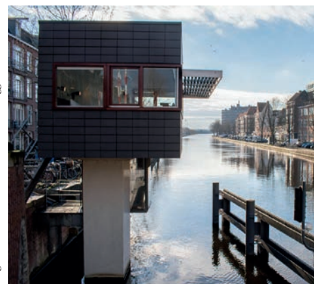
Amsterdams 28 ehemalige Brückenhäuser werden in unterschiedliche Hotelzimmer umgewandelt
