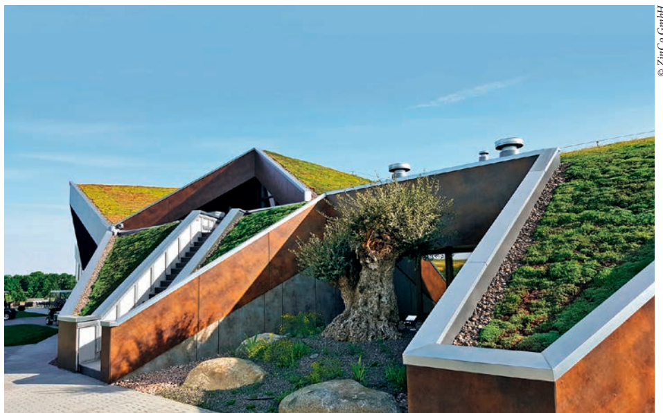
Auch expressive Dachformen bis 45° Neigung wie hier nahe Dresden können begrünt werden, die extensive Dachbegrünung links reduziert den Energieverbrauch der Klimaanlage erheblich
