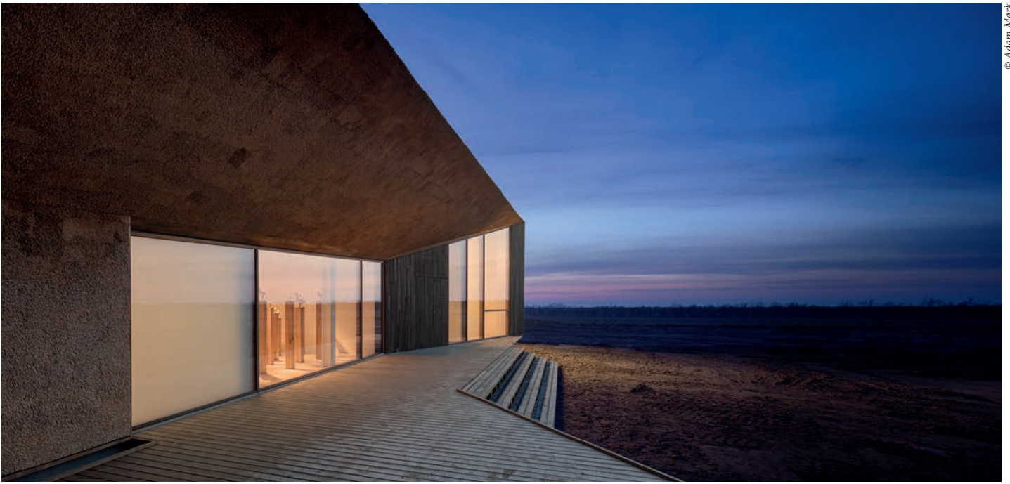
Dach und Wände des Wattenmeerzentrums in Ribe bestehen aus Reet und Lehm
