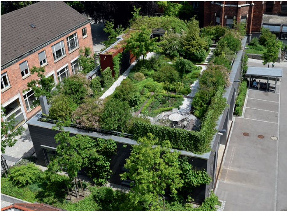
Begebarer, intensiv begrünter Dachgarten für die Mitarbeiter eines Betriebes in Norddeutschland
