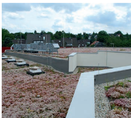
Auch expressive Dachformen bis 45° Neigung wie hier nahe Dresden können begrünt werden, die extensive Dachbegrünung links reduziert den Energieverbrauch der Klimaanlage erheblich
