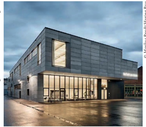
Innovativer Textilbeton als Fassade am Balletthaus Düsseldorf
