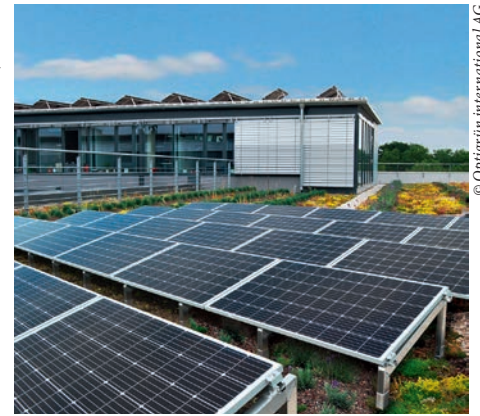
Solargründach mit extensiver Begrünung und Retentionsvolumen
