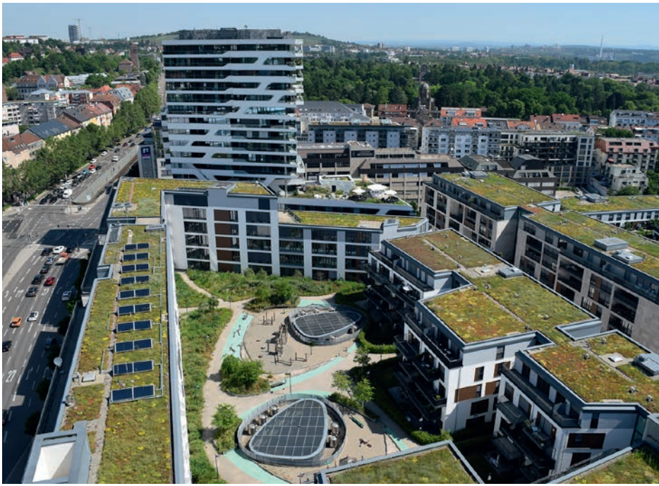
Solargründach mit extensiver Begrünung und Retentionsvolumen
