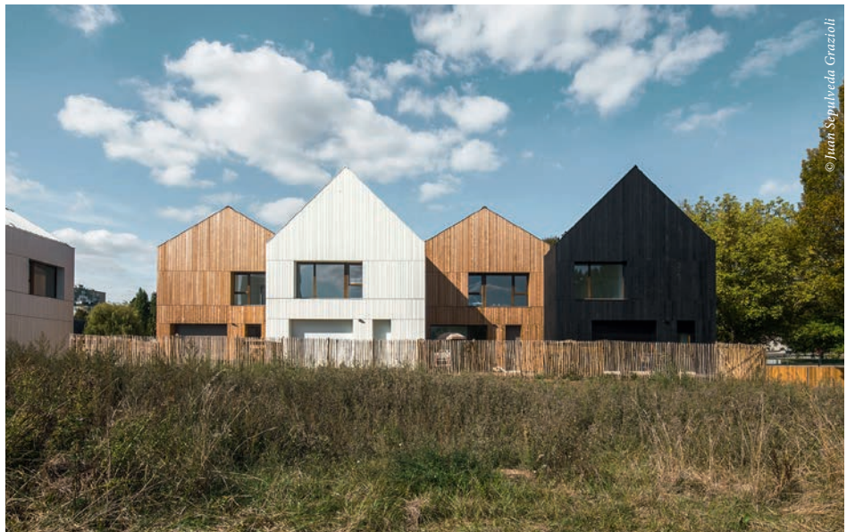
Sozialer Wohnungsbau aus vorgefertigten, strohgedämmten Holzelementen in Nogent-le-Rotrou, links Herstellung der Bauteile
