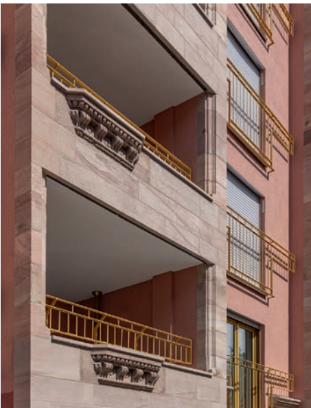
Integration abgebrochener Bauteile in den Neubau in Nürnberg
